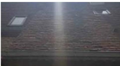
Vue d'ensemble – versant Nord
